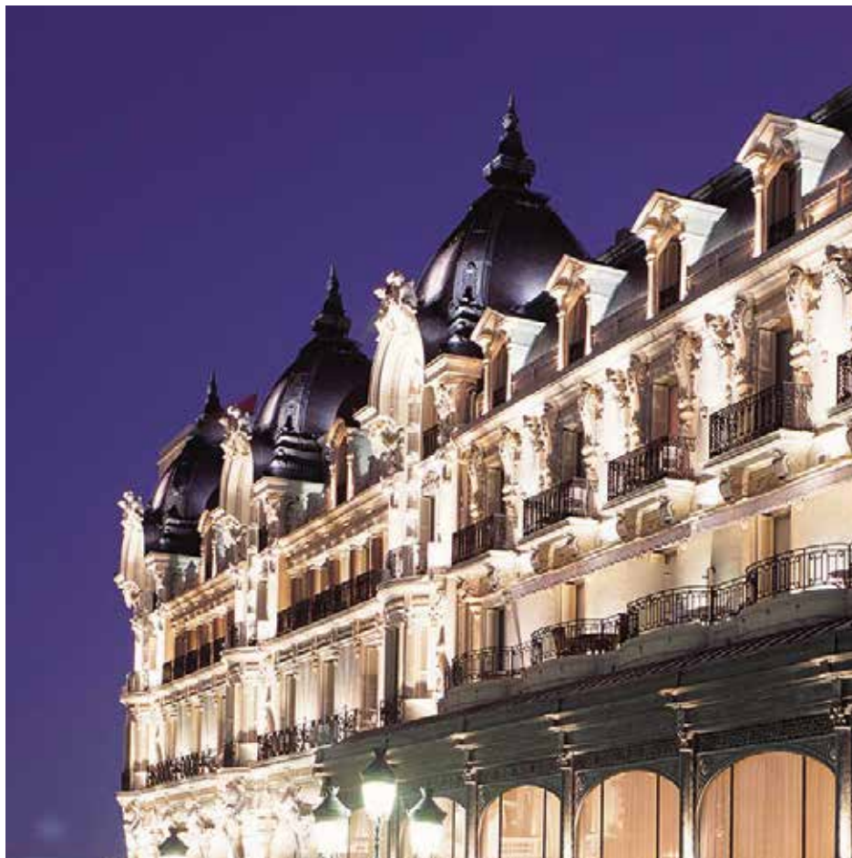
Hotel de Paris , Luogo: Principato di Monaco, Prodotto: su misura, posa a spina su disegno, Architetto: Affine Design, Anno: 2018
