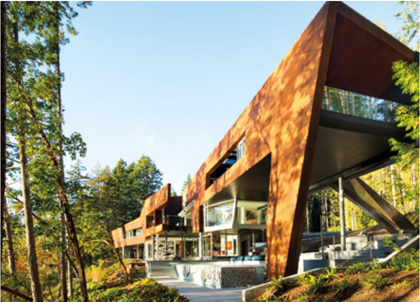
Privatresidenz Gulf Islands/ STANDORT: Vancouver - Kanada/ PRODUKT: Medoc/ ARCHITEKT: AA Robins/ Fotograf: Ema Peter/ JAHR: 2015
